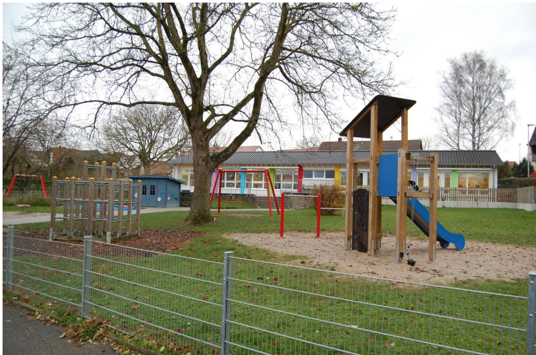
Kindergarten Biberacher Straße 4 nach Modernisierung und neu gestalteter Außenanlage November 2017, Foto: Elleser
