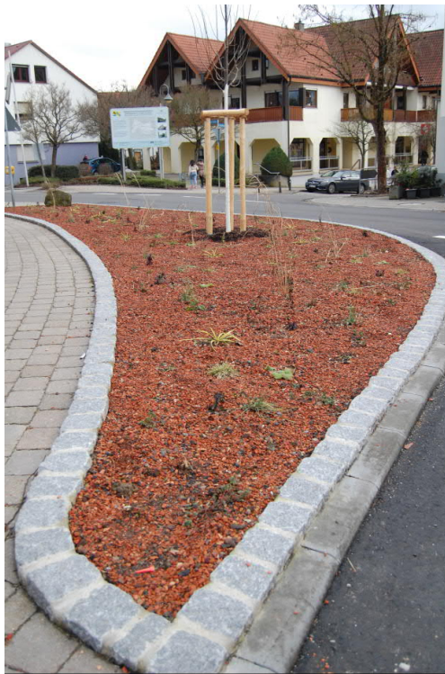
Treschklinger Straße mit Verschmälerung der überdimensionierten Einmündung in die Fürfelder Straße und Anlage eines begrünten, entsiegelten Abschnittes, Februar 2026, Foto Elleser
