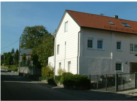
Treschklinger Straße 8 mit Stützmauer, Mai 2006, Foto: Nickel
