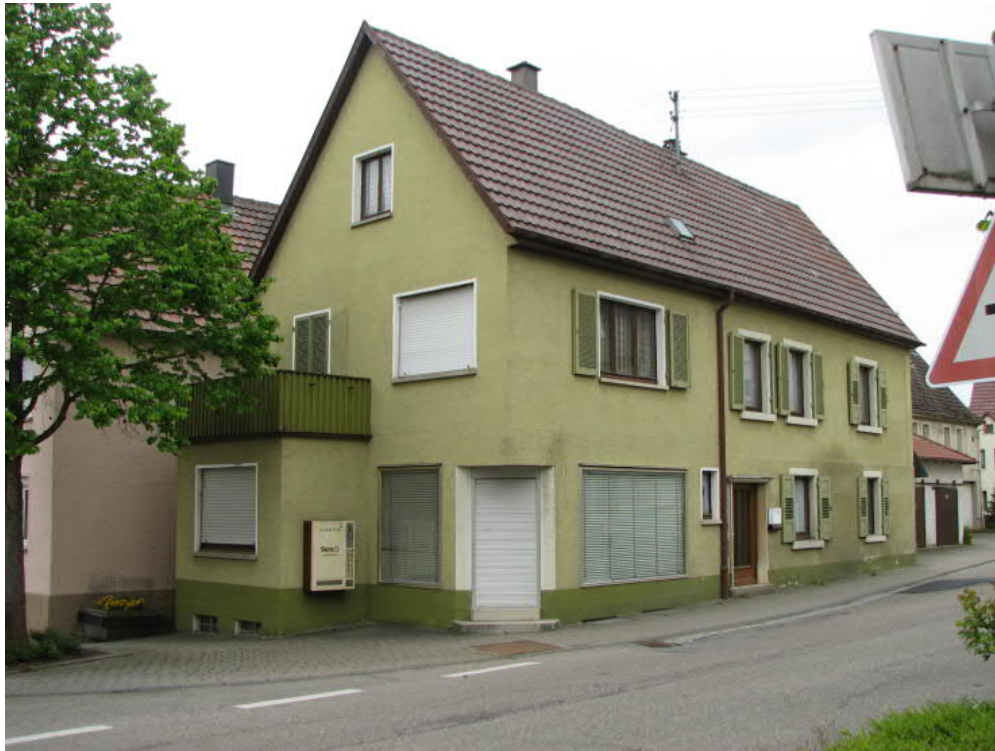
Flst. Nrn. 123/11, 123/12, Furfelder Straße 1, Mai 2011, Foto: Nickel
