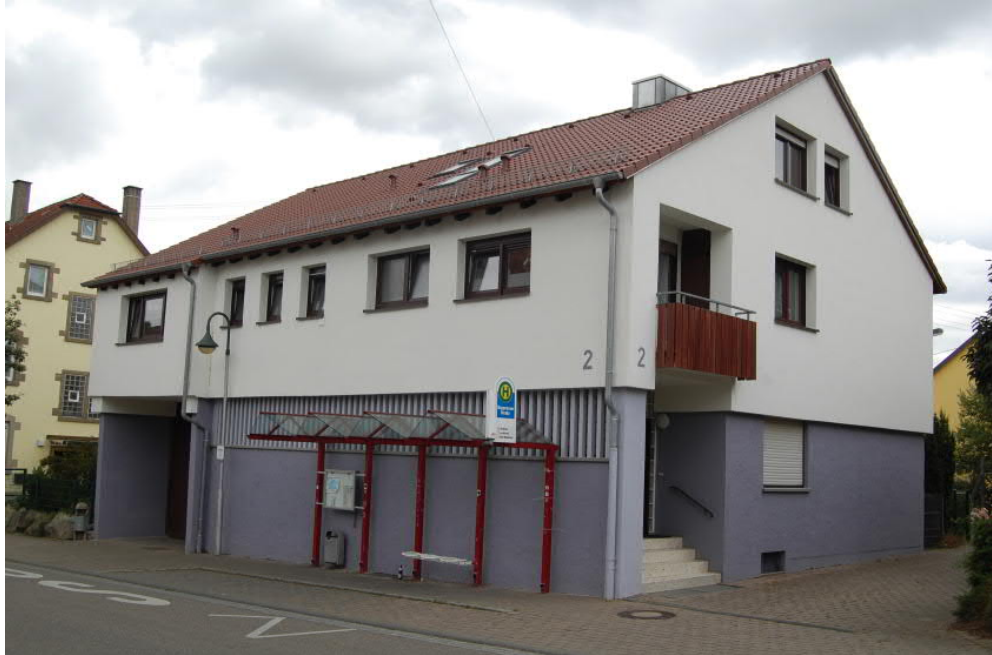
Rappenauer Str. 2 (Bauhof im Erdgeschoss und Wohnung im Obergeschoss), nach 1. Bauabschnitt, Juni 2014, Foto: Ellessen
