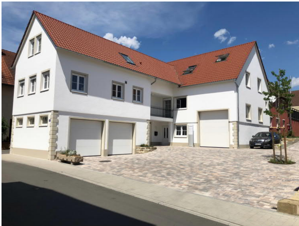
Herbststraße 17, Juni 2022, Neubau Ecke Stichstraße / Herbsstraße, Foto: Elleser
