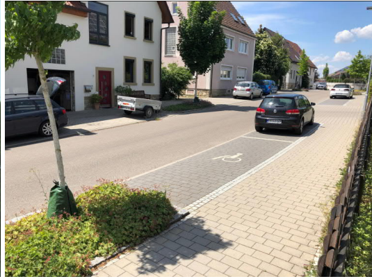
Treschklinger Straße, Längsparkplätze, Juni 2022, Foto: Elleser
