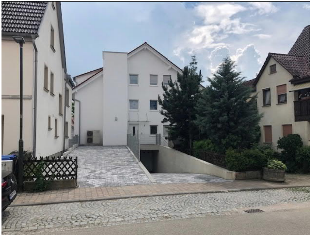
Neubau Martin-Luther-Straße 6-8, Blick TG-Zufahrt von Fürfelder Straße zw. Nr. 5 u. 9, Juli 2021, Foto: Ellessner
