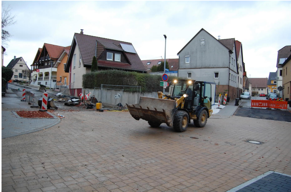
Kirchhausener Straße, Pflaster und Straßenbelagsarbeiten November 2017, Foto: Elleser
