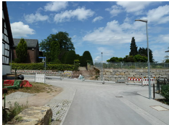
Treschklinger Straße 8 mit Stützmauer im Bau, Juli 2015, Foto: Elleser
