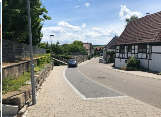
Treschklinger Straße 8 mit neuer Stützmauer, Juni 2022, Foto: Elleser
