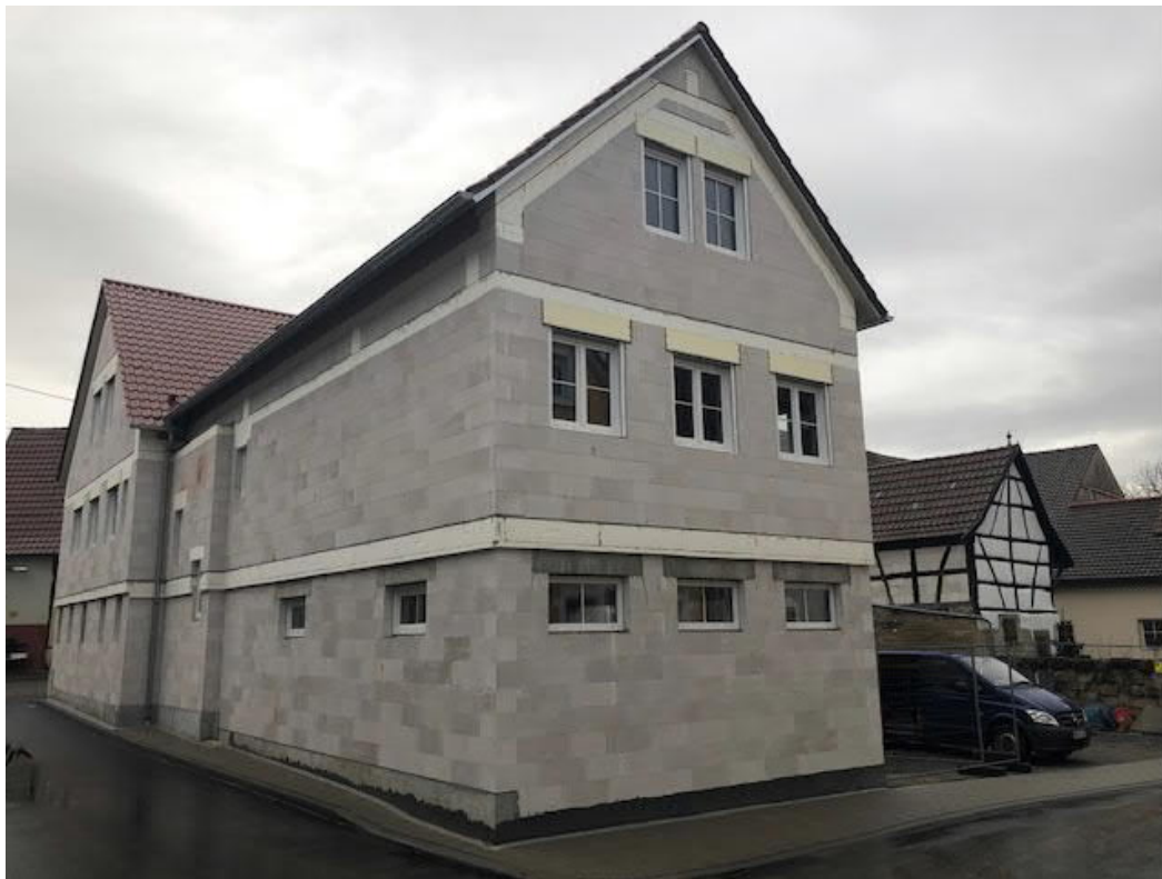
Herbststraße 17, Dezember 2020, Rohbau Ecke Stichstraße / Herbsstraße, Foto: Elleser
