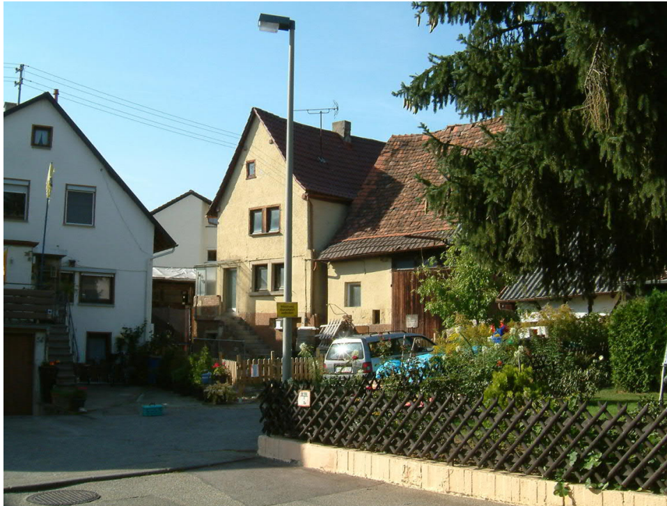
Martin-Luther-Straße 32, im September 2011, Foto: Nickel
