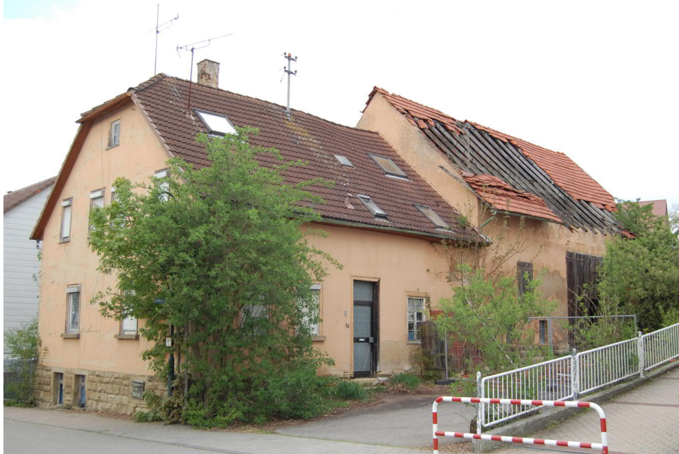
Fürfelder Straße 16, im April 2011 vor erfolgter Freilegung, Foto: Elleser
