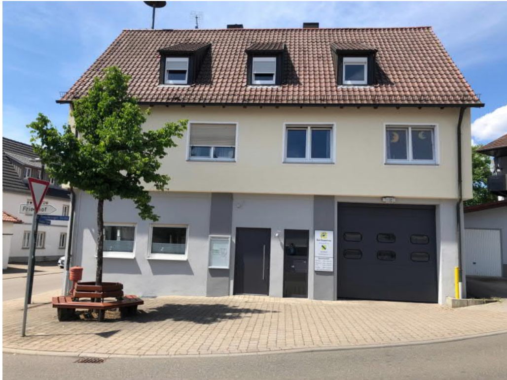
Treschklinger Straße 1 (ehem. Feuerwehr), Umbau des städtischen Gebäudes für Verwaltungsstelle / Bürgerbüro und Bauhofnutzung (Büro + Lager), Juni 2022, Foto: Ellesser
