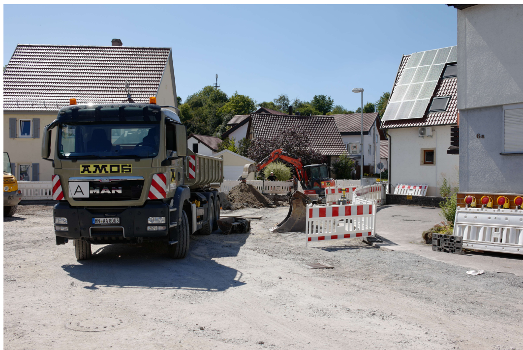
Abbildung 12: Grombacher Straße Kreuzungsbereich Herrenweg, während BauausführungQuelle: KE, Foto vom 21.07.2020
